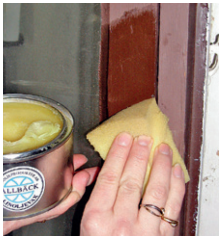
Leinölwachs auf gestrichenen Flächen oder unbehandeltem Holz
