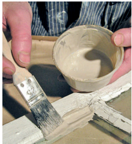
Kittbrei, einfache „Alterungsverzögerungs“-Maßnahme
