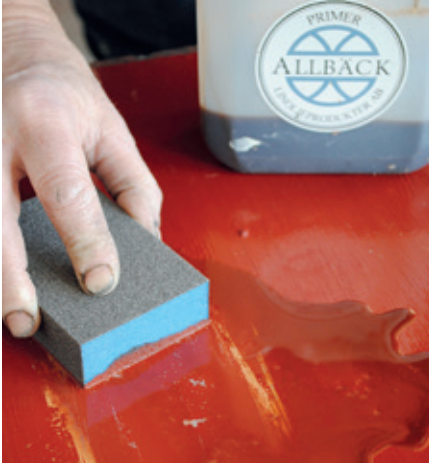
Unebene „Rosinenhaut“ nass mit Primer wegschleifen
